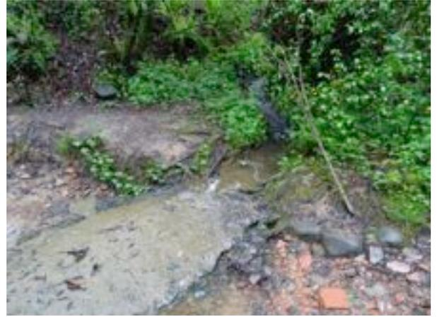
Il torrente Puzzola ha invaso la strada. L'argine sulla destra idrografica del fosso è stato completamente eroso. Il lastricato è scomparso e il passaggio è ridotto a una striscia di terra rialzata e scivolosa sulla sinistra
