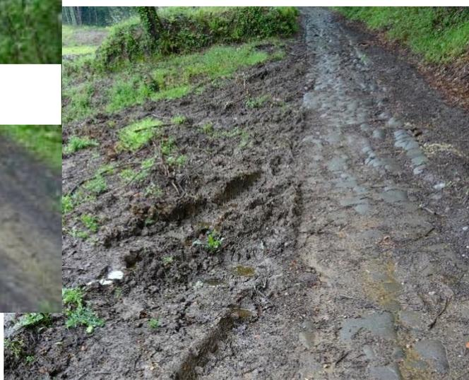
*Lavori di disboscamento sul lato sinistro della strada lastricata, realizzati nel 2022, con passaggio sul selciato di grossi mezzi e conseguenti degradi*
