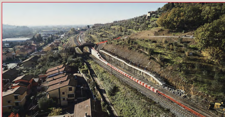
Raddoppio della linea ferroviaria Firenze-Viareggio, nella tratta Pistoia-Montecatini Terme.
